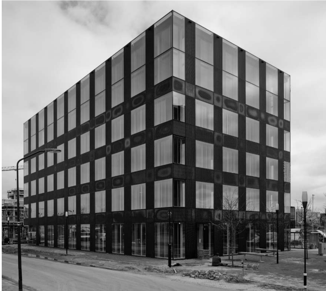
De nieuwbouw van het Openbaar Ministerie te Lelystad, door Hootsmans architectuurbureau. Foto Maarten Noordijk
